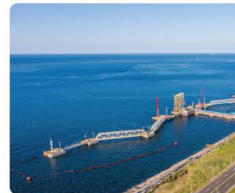
天津港口枢纽基础设施建设项目
