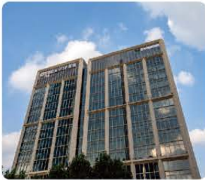
位于上海南外滩的集团总部
